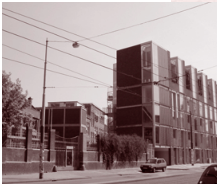
De nieuwbouw aan de Borneostraat waarin het door Stadsherstel verworven bedrijfsgedeelte grenzend aan gemaal Zeeburg
