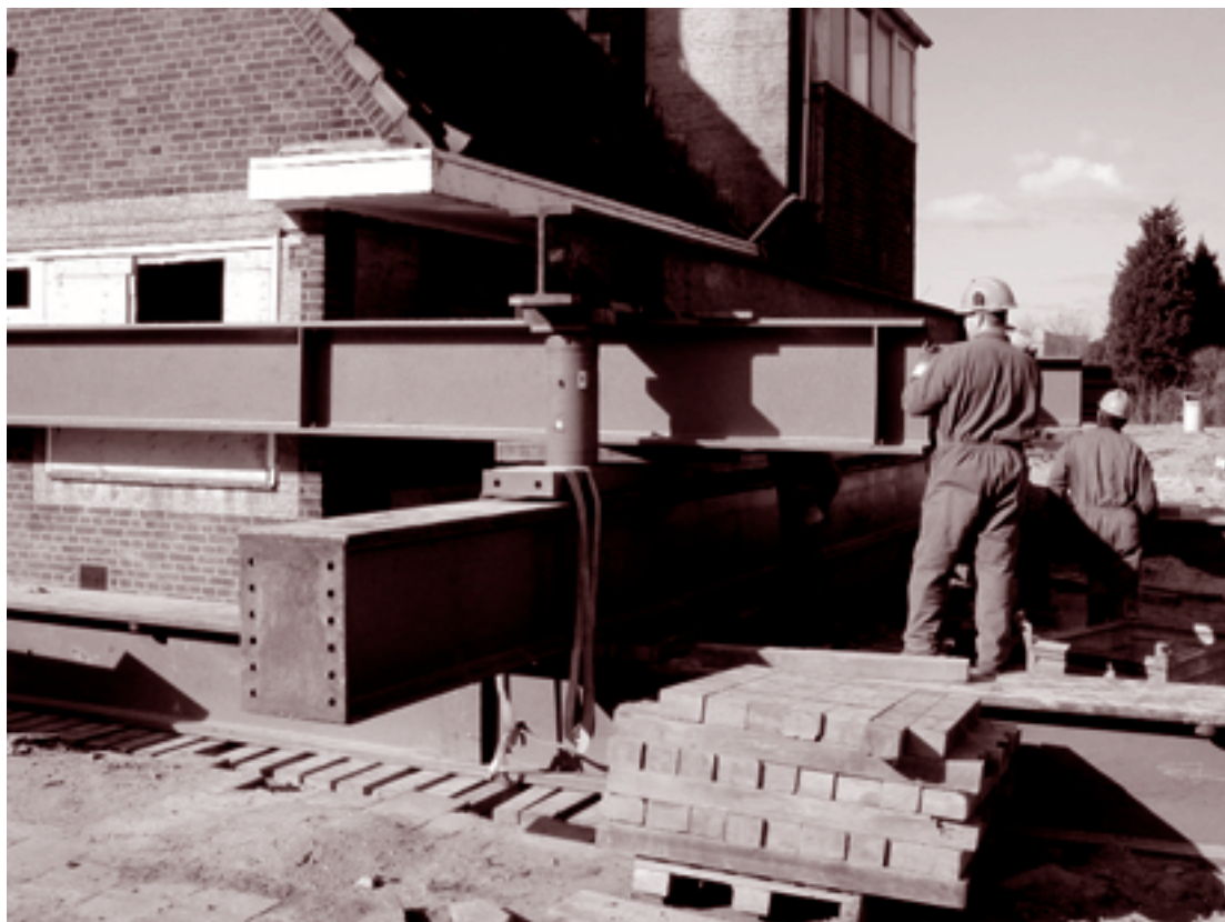
Een huzarenstukje: Stadionplein 18 in beweging
