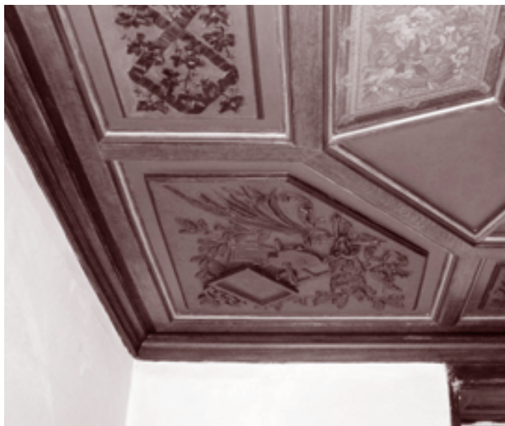
Reguliersgracht 63: het volgens origineel model gegoten nieuwe plafondornament van de voorkamer tweede etage
