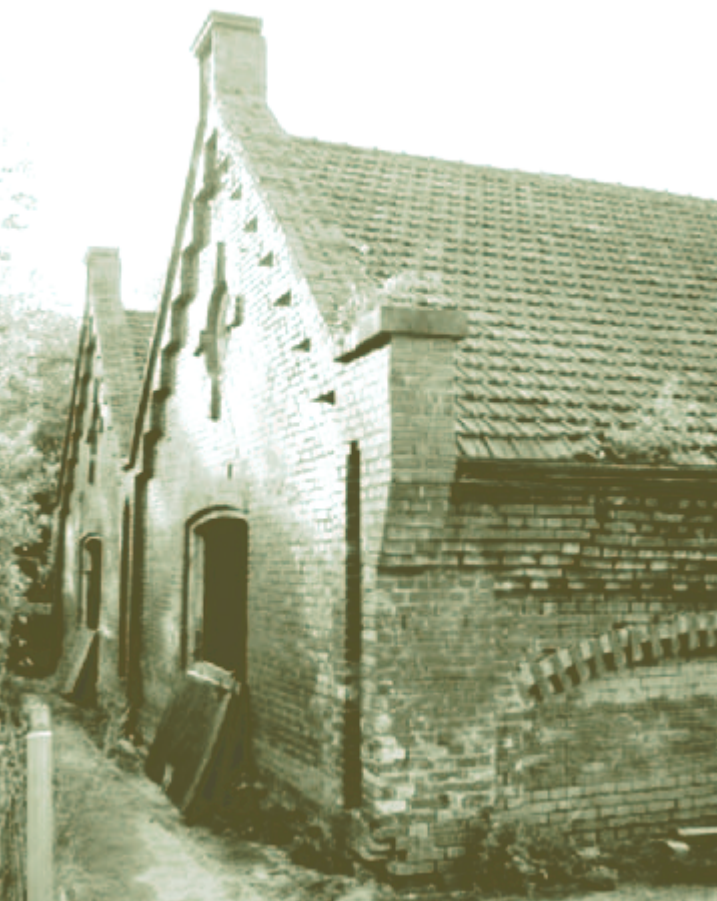
De meststallen met het markante metselwerk
