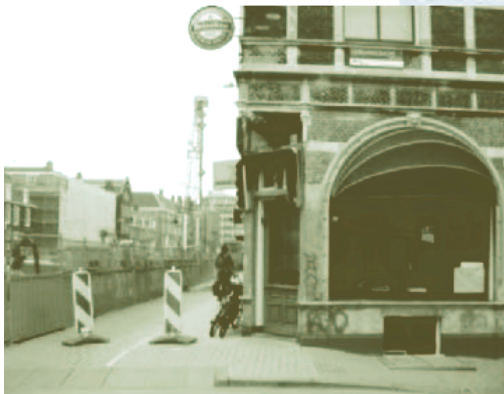
Vijzelgracht 63 en de diepwand, een confrontatie
