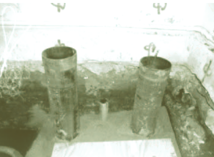
De stalen buispalen door de fundering van het bolwerk Het Ooster Blokhuis
