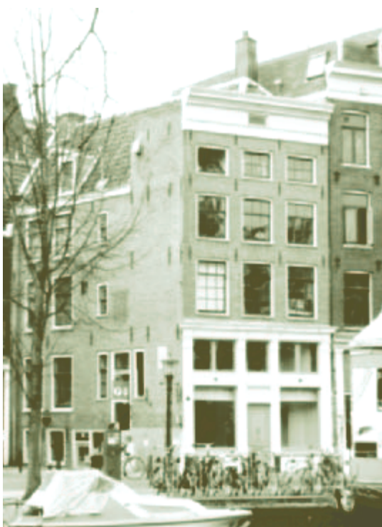
Een stalen onderpui met nieuwe klassieke betimmering: Prinsengracht 206
