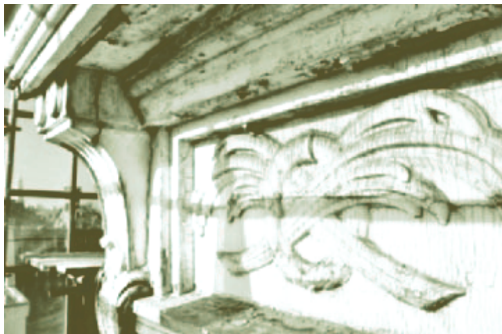
Achttiende-eeuws houtsnijwerk in de gevellijst van Kalkmarkt 10
